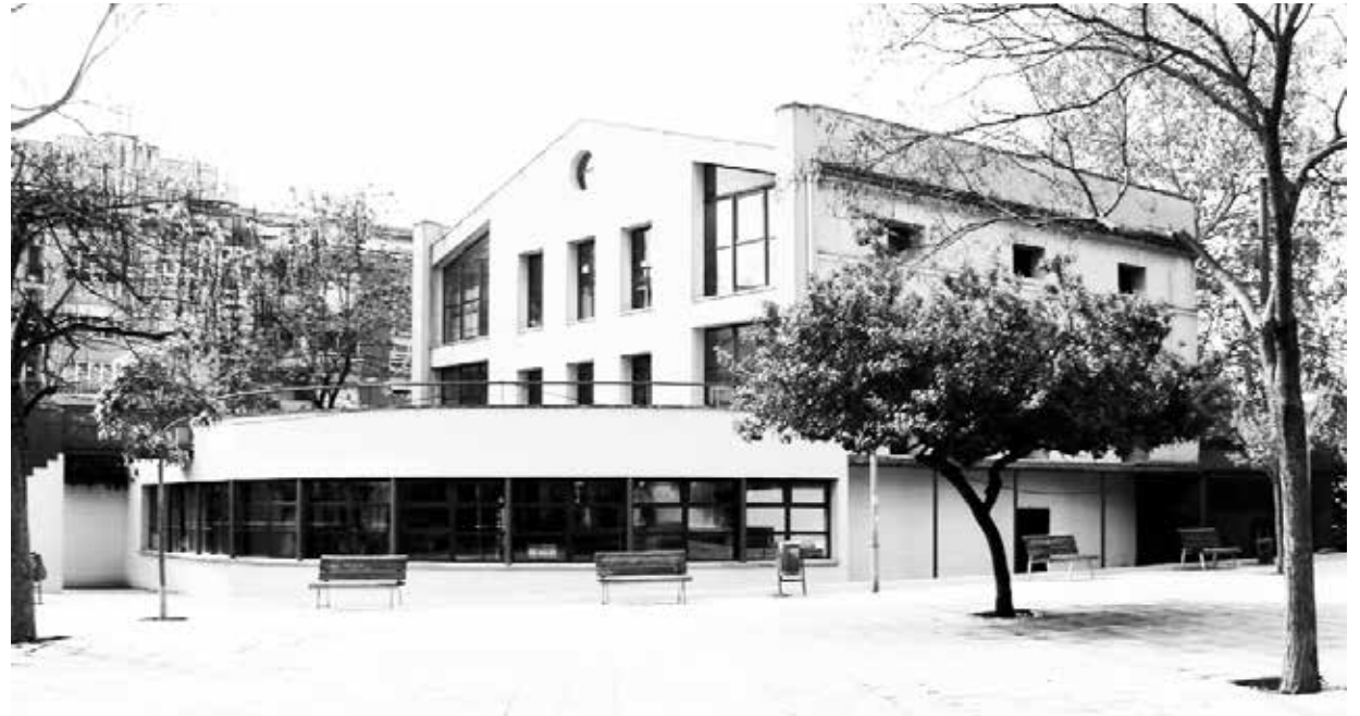
F1. L'edifici actual de Ca n'Altimira (antiga biblioteca municipal de Cerdanyola del Vallès)
