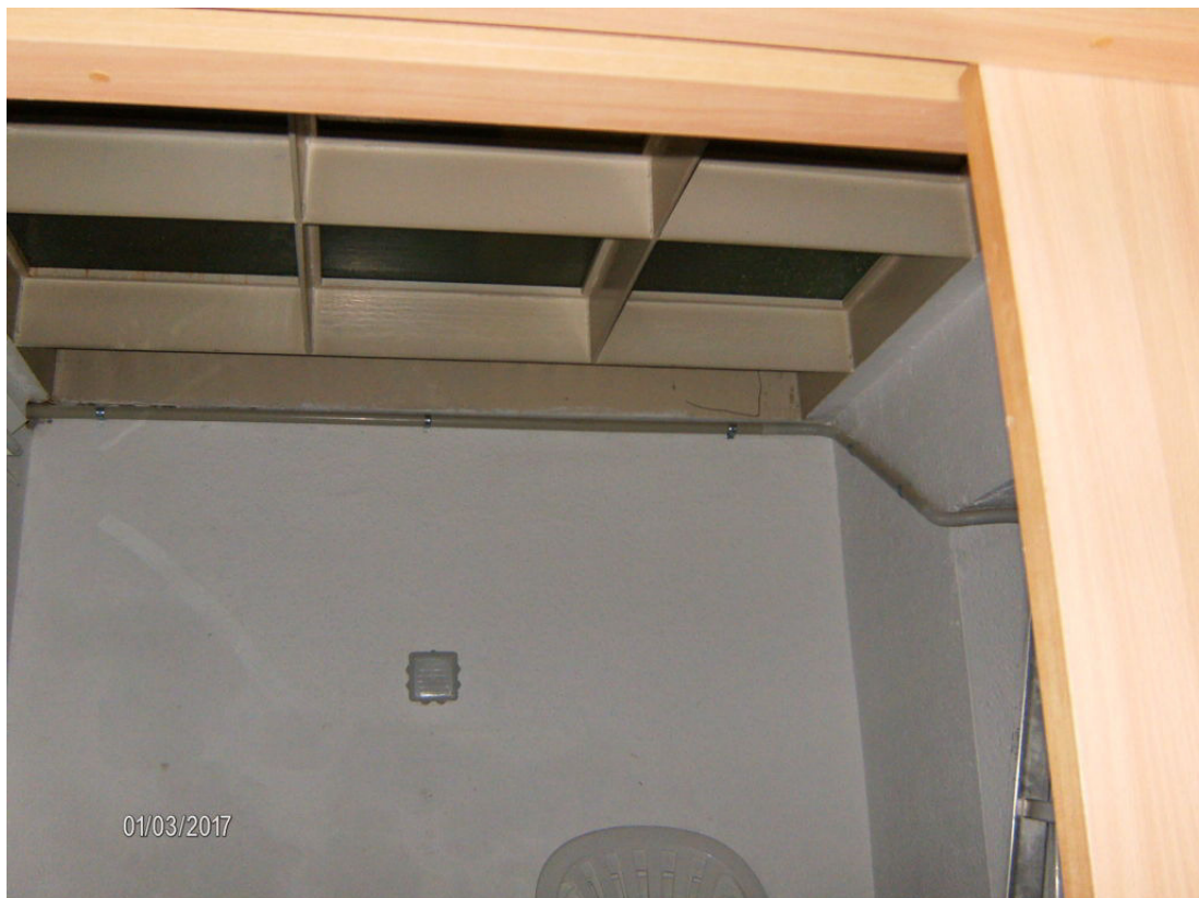
Sostre de magatzem on s'ubicarà el nou lavabo
