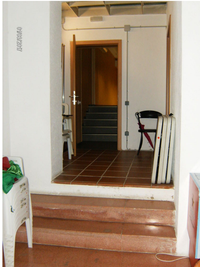
Escala connexió entre edificis. Zona nou lavabo
