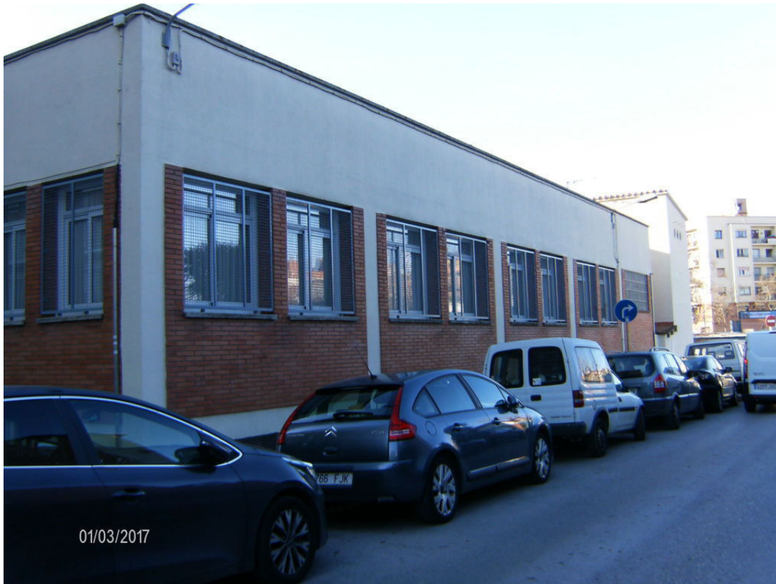
Façana c/ Zurbaran
