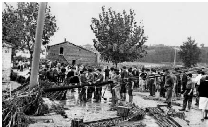
Treballs de desenrunament a la zona del Pont Vell
