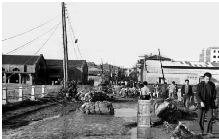
Afectació a la zona del Cellar Cooperatiu de Ripollet
