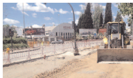
Inici de les obres del col·lector a l'alçada del carrer de Santa Anna
