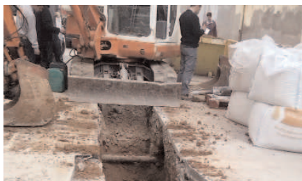
Obres del col·lector al carrer de Sant Casimir
