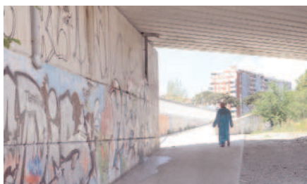
Construcció d'una vorera d'accés al CAP II des de la passera de les Fontetes
