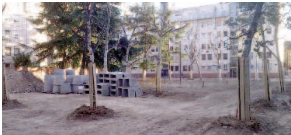
Obres de reurbanització a la plaça d'Andorra
