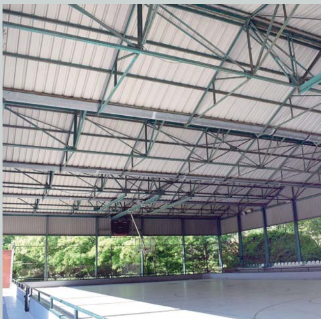
La primera fase dels treballs seran de neteja de la coberta
