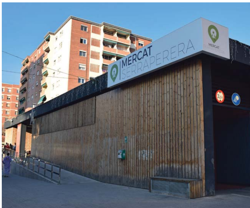
Fachada del Mercado Municipal Serraperera
