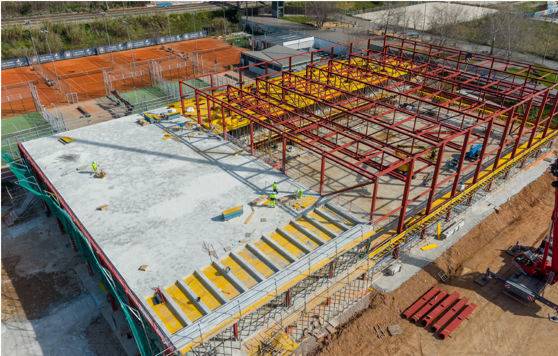
Las obras del pabellón de la ZEM Riu Sec avanzan a buen ritmo
