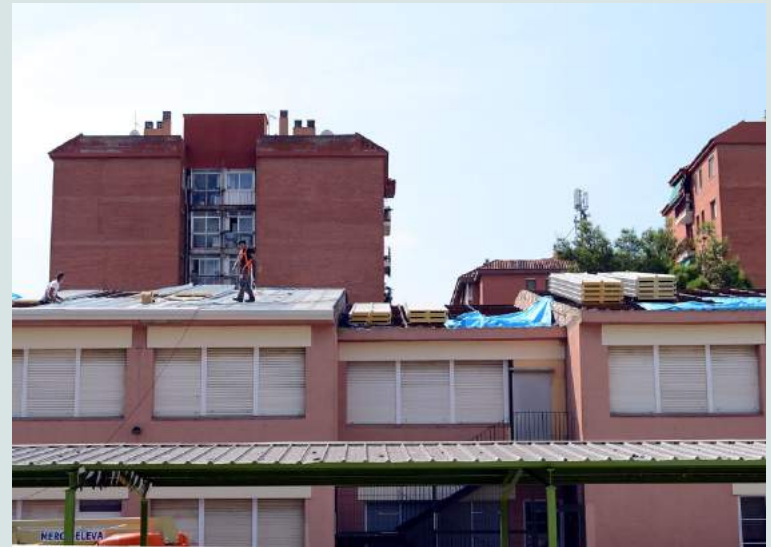
Treballs a la taulada de l'Escola Serraparera, l'any 2017
