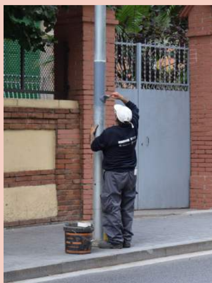
Operari repintant un fanal al carrer de Francesc Layret
