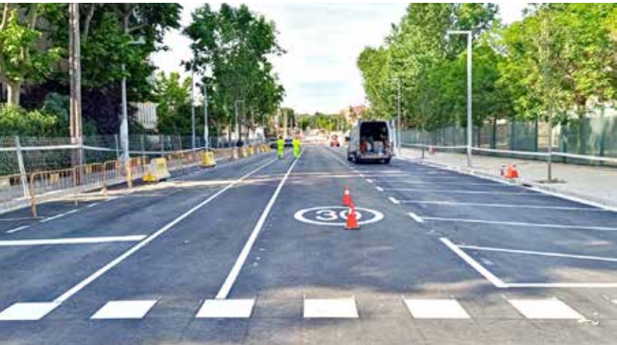
Trabajos de pintura horizontal en la avenida Roma
