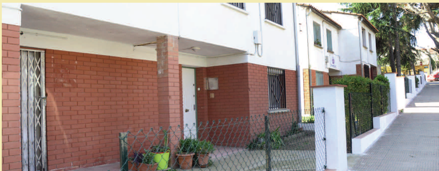
A l'exterior s'ha substituït la tanca que envolta els edificis, s'ha condicionat els jardins i s'ha substituït l'enllumenat interior i exterior de les cases
