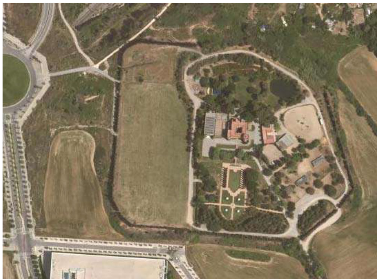
Al centre de la imatge la plataforma situada al pla +11,50 que forma un gran talús, de més de 9 metres d'alçada, amb front a la pròpia parcel·la i al carrer de Creu Casas i Sicart
