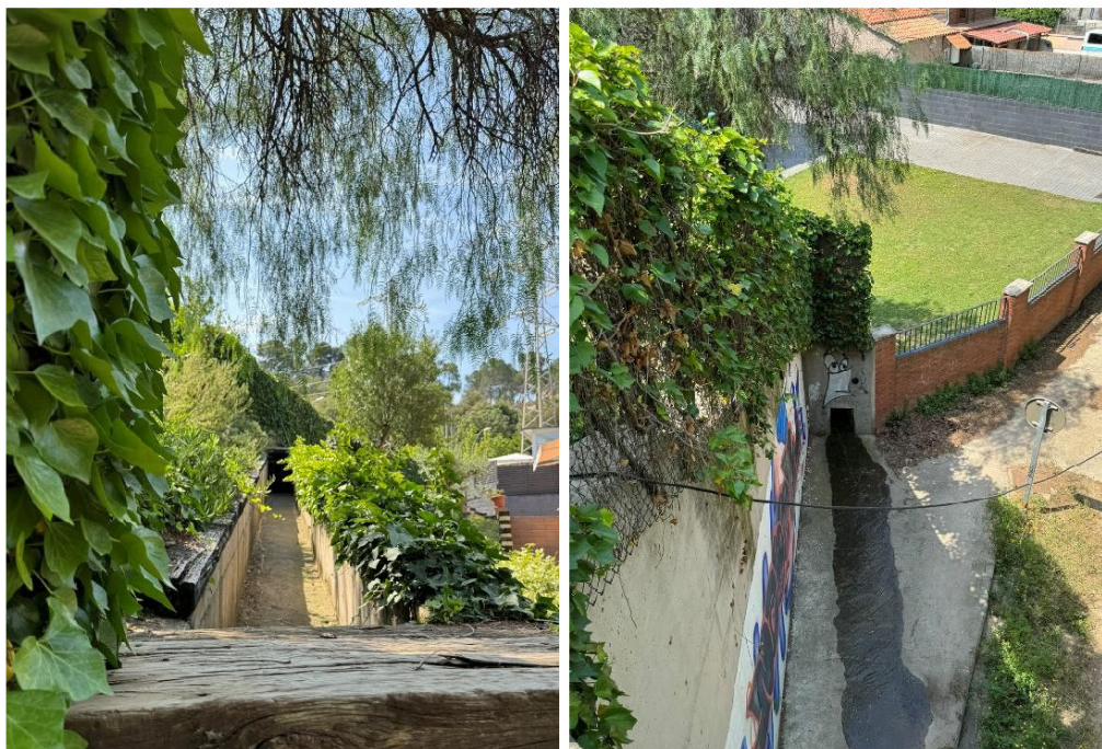
Figura 7 – Canal de formigó existent
