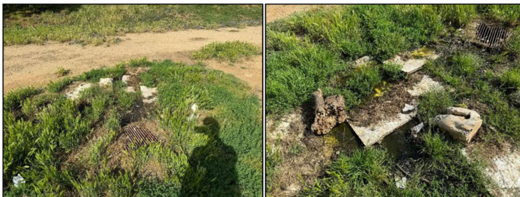
Figura 1. Clavegueram trencada i embornal
