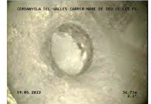
P1 A 2276_c128df74-0619-4e56-b02c-fb483dd62d17_20220519_092631_220.jpg, 00:03:53, 34.70 Unión, conexión abierta,, altura: 81mm, anchura: 81mm a 10 Reloj / A POZO
