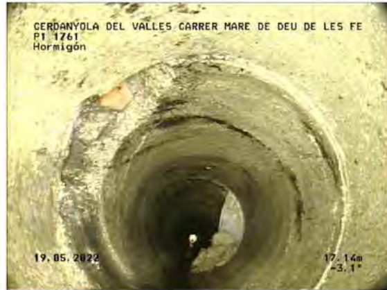
P1 A 1761_ee3944ed-c85b-4435-8c7e-ef6e5be24487_20220519_095423_609.jpg, 00:01:44, 17.14 Unión, conexión abierta,, altura: 81mm, anchura: 81mm a 9 Reloj
