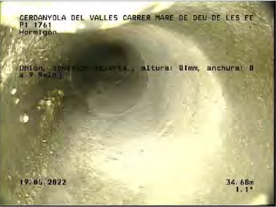
P1 A 1761_6759669a-dd4f-494e-9d13-35f75952d164_20220519_095757_486.jpg, 00:04:47, 34.67 Unión, conexión abierta,, altura: 81mm, anchura: 81mm a 9 Reloj
