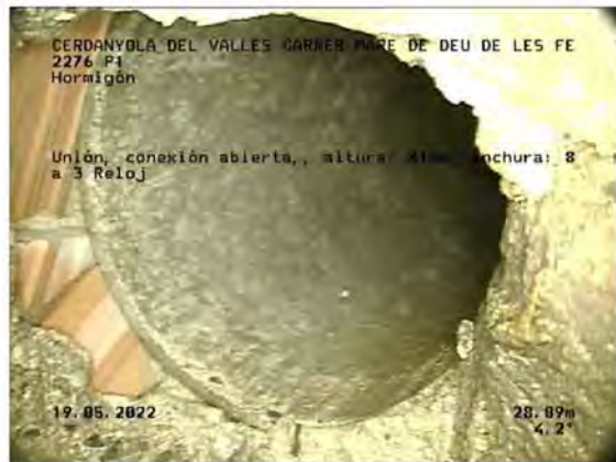
P1 A 2276_101e7d3b-1d79-47d6-b7a1-2301bfc5959_20220519_092506_823.jpg, 00:02:55, 28.89 Unión, conexión abierta,, altura: 81mm, anchura: 81mm a 3 Reloj
