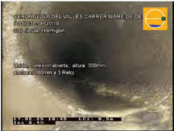
17_02_2025 10_43_56_493556ca-1b40-476b-baba-fecc607a2185_20250217_104534_042.jpg, 00:00:12, 0.50m Unión, conexión abierta,, altura: 300mm, anchura: 300mm a 3 Reloj
