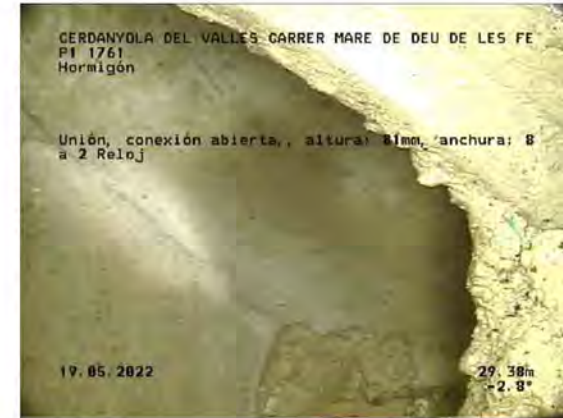
P1 A 1761_6d36ff40-536c-4448-a8b9-e0a17f20592e_20220519_095643_569.jpg, 00:03:43, 29.38 Unión, conexión abierta,, altura: 81mm, anchura: 81mm a 2 Reloj / HORMIGÓN
