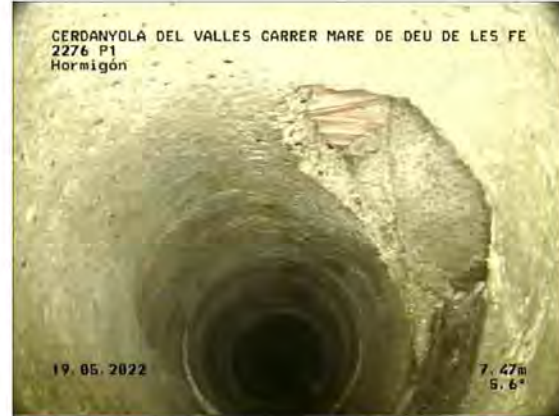
P1 A 2276_528db9fc-1862-4a5d-bdf2-57336f8ec567_20220519_092237_603.jpg, 00:00:36, 7.95 Unión, conexión abierta,, altura: 81mm, anchura: 81mm a 2 Reloj
