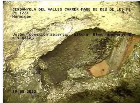
P1 A 1761_33f36dda-68e6-4b1d-a65c-54f538494b0d_20220519_095417_412.jpg, 00:01:44, 17.14 Unión, conexión abierta,, altura: 81mm, anchura: 81mm a 9 Reloj
