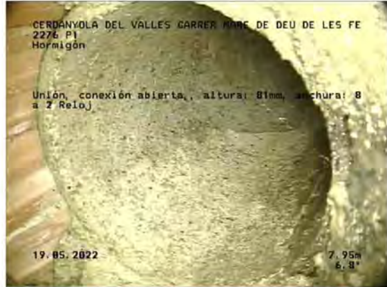
P1 A 2276_637a061b-0daf-4a1d-b90d-c5244b1b85ae_20220519_092231_751.jpg, 00:00:36, 7.95 Unión, conexión abierta, altura: 81mm, anchura: 81mm a 2 Reloj
