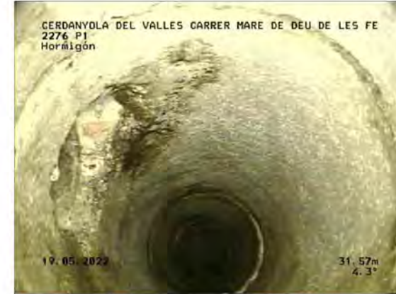
P1 A 2276_ced076b8-1aa8-4b65-ae6a-1c55d2316e6d_20220519_092552_304.jpg, 00:03:20, 31.85 Unión, conexión abierta,, altura: 81mm, anchura: 81mm a 10 Reloj
