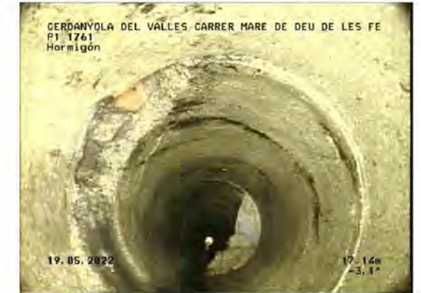
P1 A 1761_ee3944ed-c85b-4435-8c7e-ef6e5be24487_20220519_095423_609.jpg, 00:01:44, 17.14 Unión, conexión abierta,, altura: 81mm, anchura: 81mm a 9 Reloj
