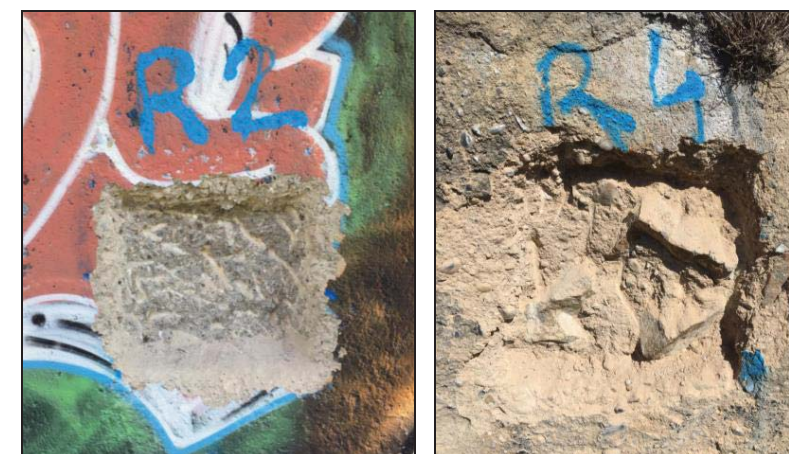
Rases efectuades a la zona de la cala C-2, molt semblant a les de les zones C-1 i C-3 (esquerra) i de la cala C-4, on s'observen els blocs de roca (dreta).
