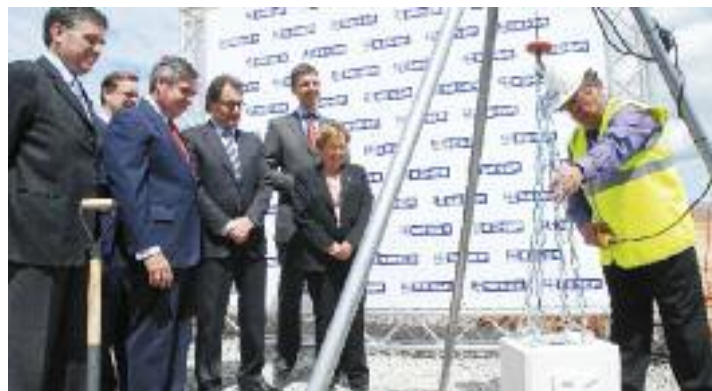
Col·locació de la primera pedra
