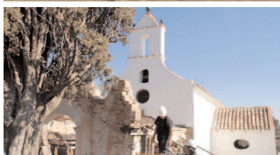
Els treballs de rehabilitació han recuperat un edifici força malmès
