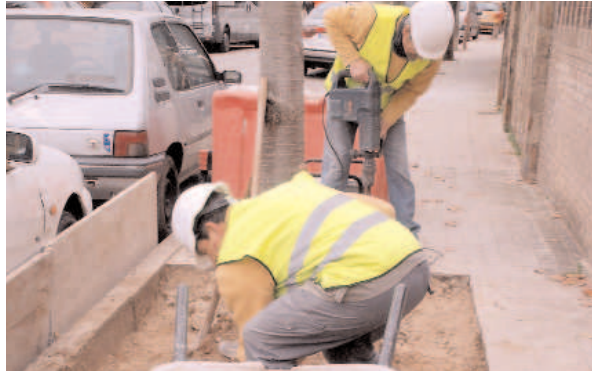
Arranjament de voreres a l'avinguda d'Europa
