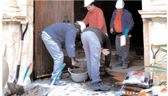
Treballs de col·locació del terra a l'església vella del cementiri
