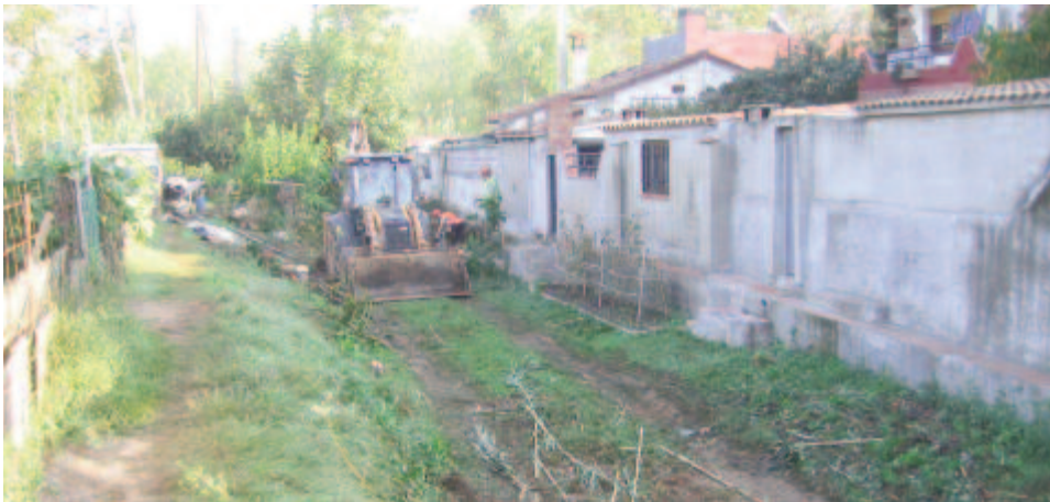
Obres d'acondicament del torrent dels Toros a la zona de Montflorit
