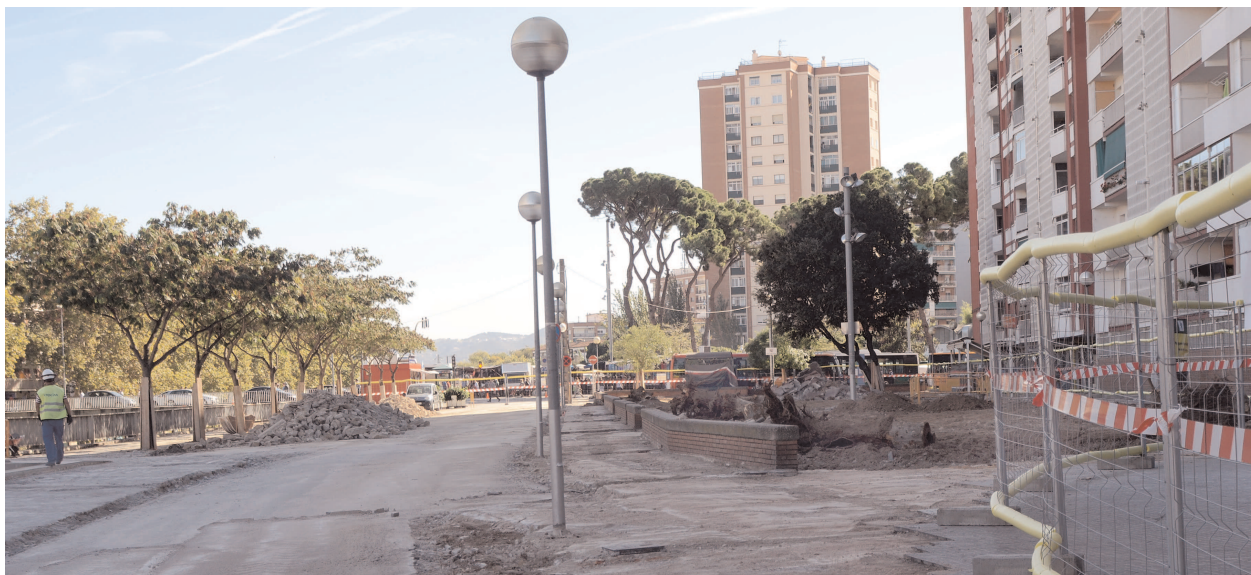
Aspecte general de l'estat de les obres
