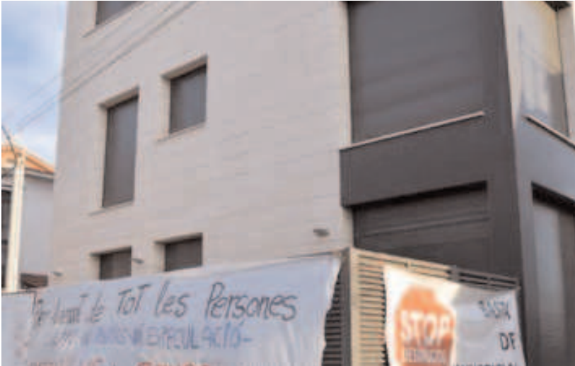
Un dels edificis amb habitatges buits sense empadronament detectats
