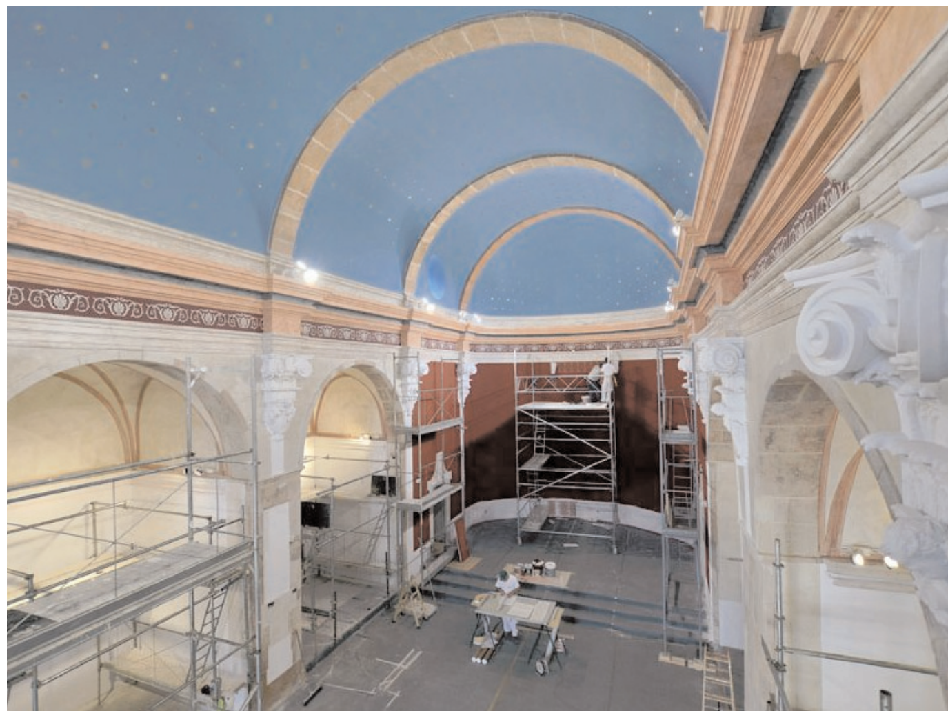
Els darrers treballs de restauració van centrar-se en la decoració amb pintura
