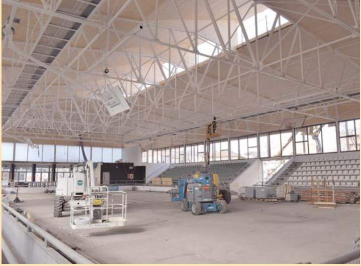
Les obres s'han centrat, entre d'altres aspectes, en el sostre del pavelló
