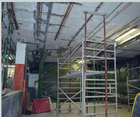
Les obres a la coberta de la pista de La Boina avancen a bon ritme.
