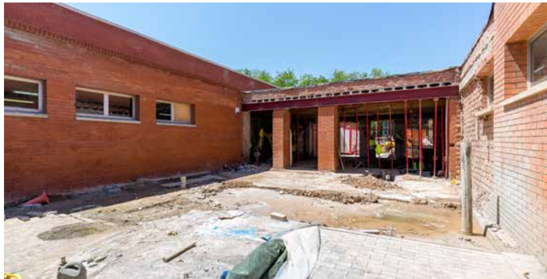
Las obras afectan al edificio central del equipamiento
