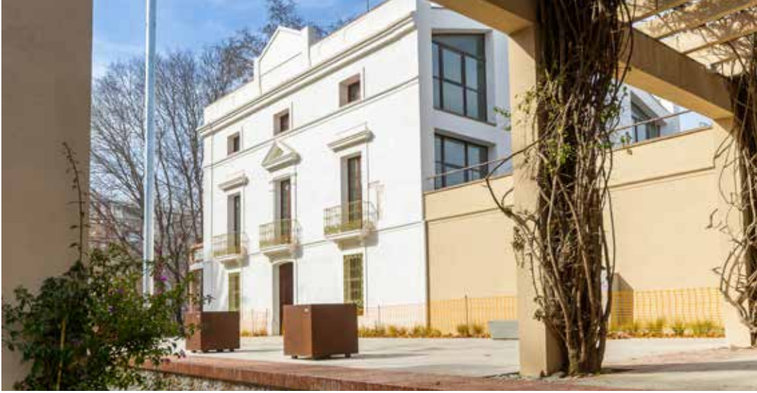
Imagen del exterior de la Masia Ca n'Altimira después de las obras de mejora del entorno
