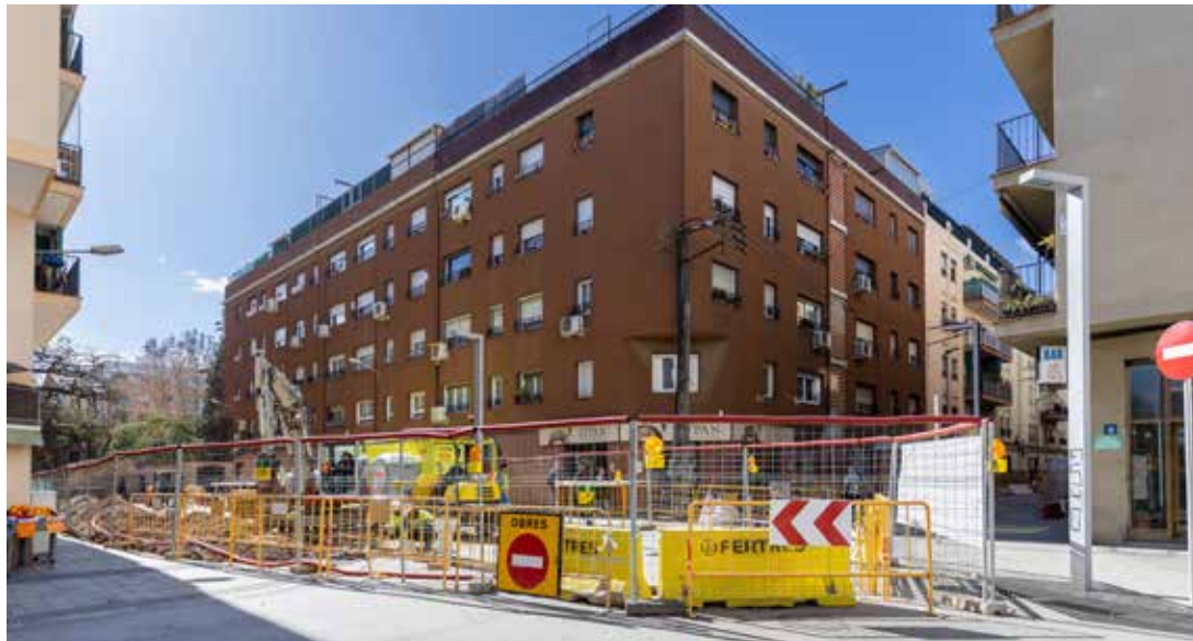
Las obras corresponden a la segunda fase de la zona de Santa Marcelina
